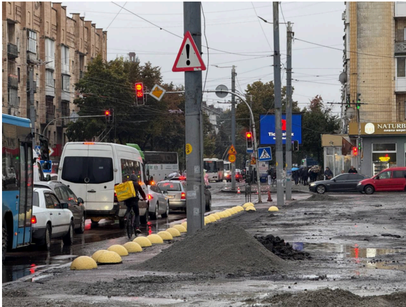
На фото: Ремонт частини вулиці Київської
